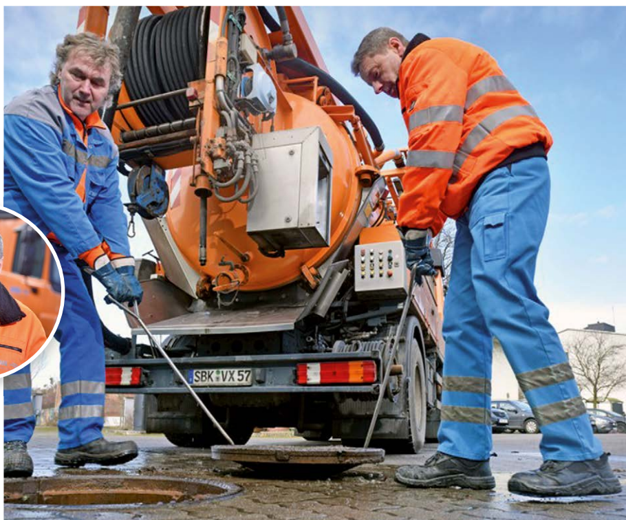
Bei der Arbeit: Roland Menz (r.) und Frank Rose, Vorarbeiter für den Bereich Kanalnetz, sorgen mit Unterstützung der Spezialtechnik für einen reibungslosen Abfluss des Abwassers.
